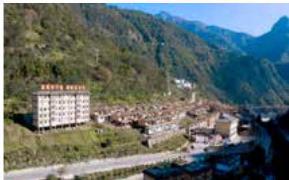
国家开发银行云南省分行支持的贡山县南大门易地扶贫搬迁安置点
